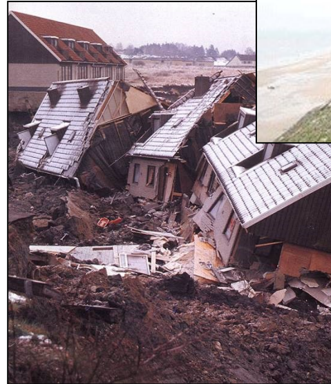
Tuve 1977 , 9 döda, 300 skadade
