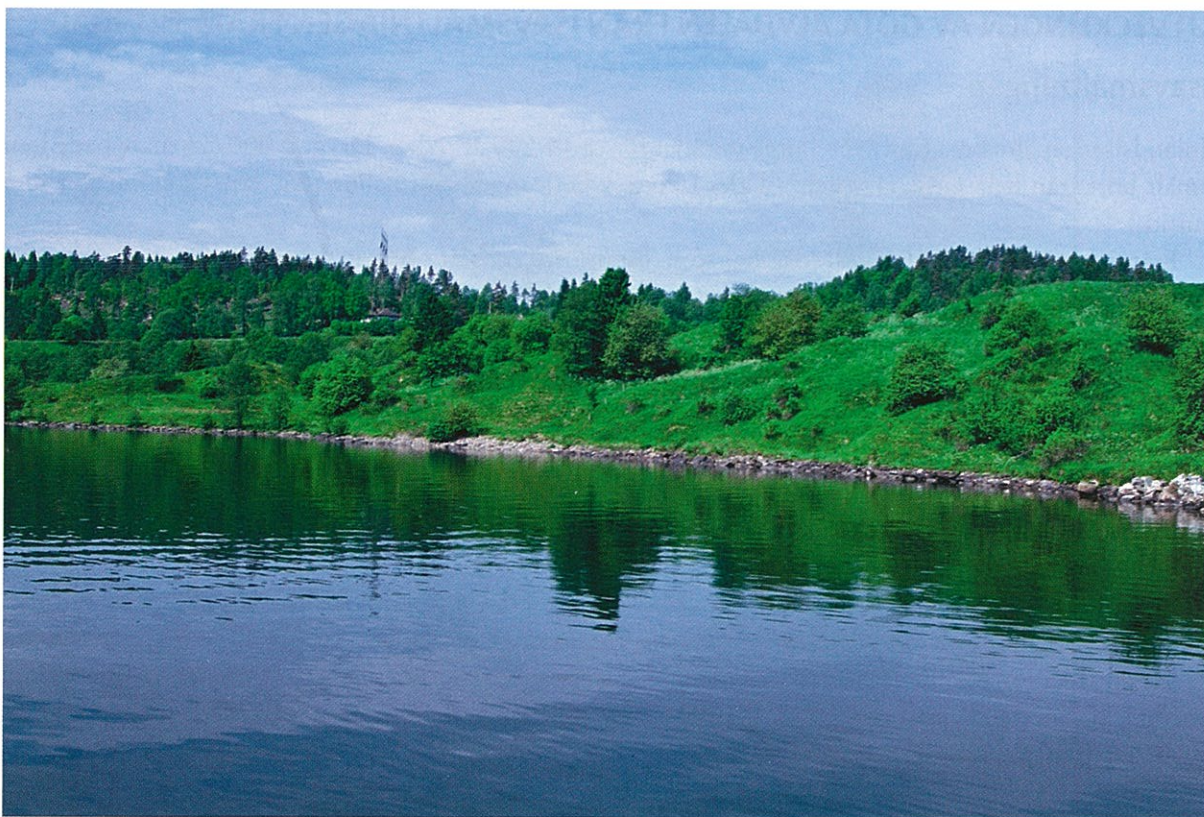
Fig. 12. Brinkar av glacial lera som skyddas av stenskonig norr om Lilla Edet. Foto Fredrik Klingberg. Eroded slopes consisting of glacial clay are common north of Lilla Edet. Rock revetment is visible on the shore.
