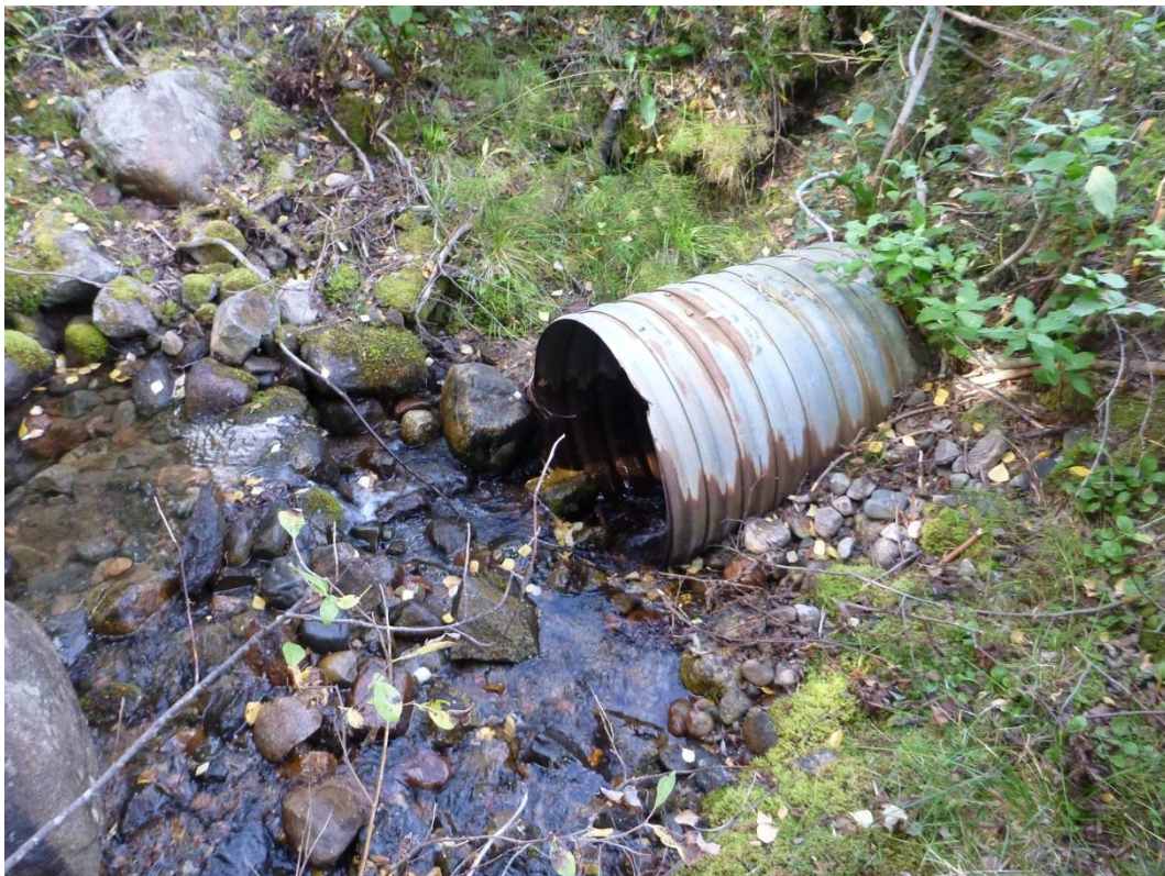
Åkerdal - karteringspunkt 1. Inloppet till trumma under väg, diameter 1,0 m
