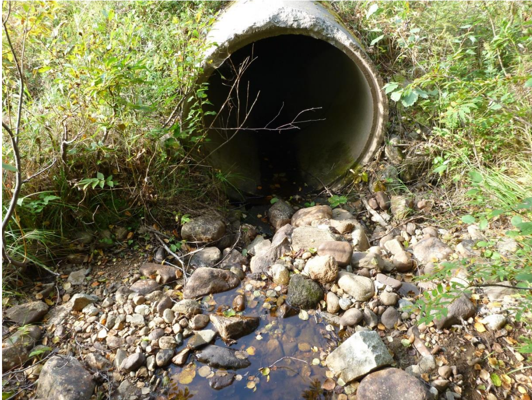
Asplövberget - karteringspunkt 4. Inloppet till vägtrumman, inget material i trumman.
