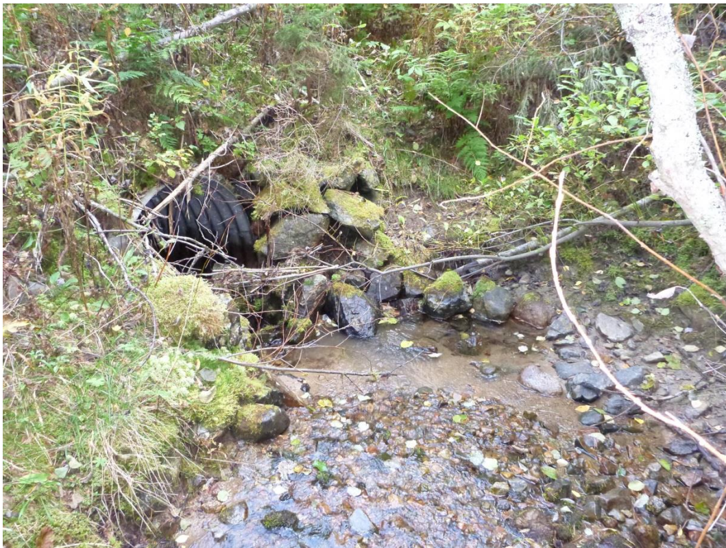
Åkerdal - karteringspunkt 2. Inloppet till trumma under väg, diameter 1,0 m. Transporterat material finns i trumman.
