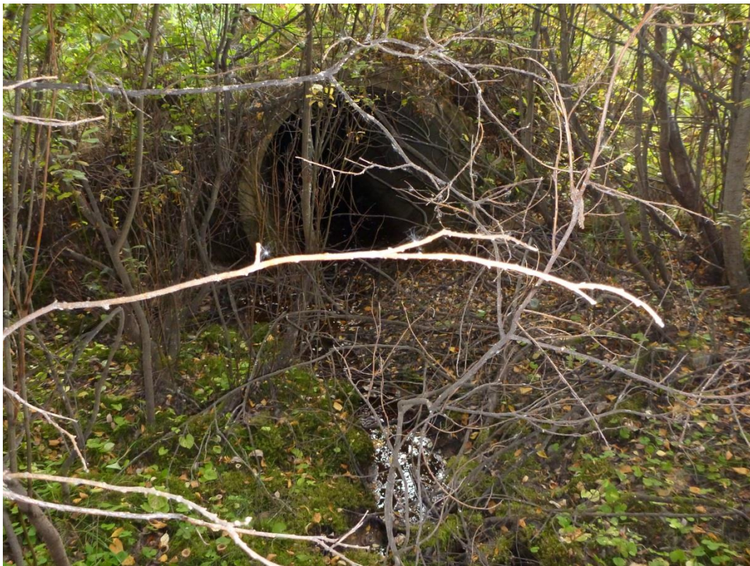
Bredsel - karteringspunkt 4. Inloppet till trumma under väg, diameter 1,5 m
