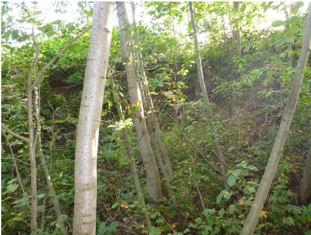
Hundberget - karteringspunkt 3. Mindre ras i en av sidoslänterna vid karteringspunkten.
