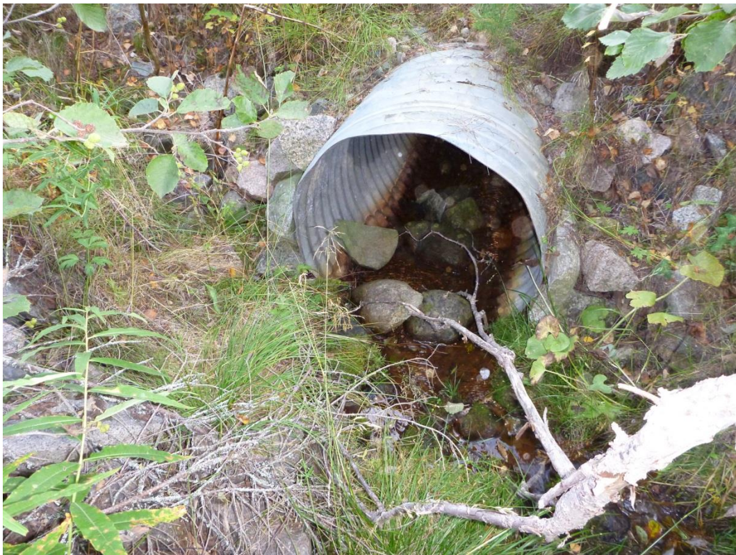
Bredsel - karteringspunkt 3. Inloppet till trumma under väg, transporterat material i trumman.
