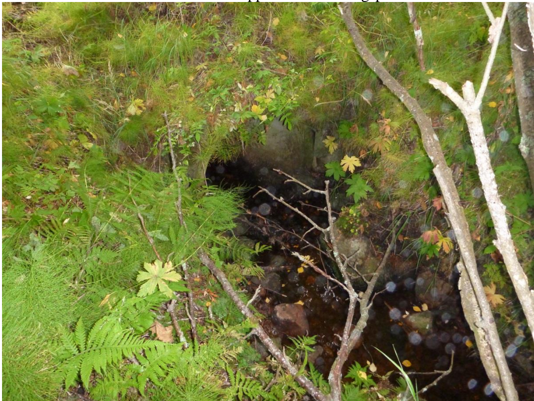
Gallejaur - karteringspunkt 3. Vägtrumma med diameter 1,0 m.
