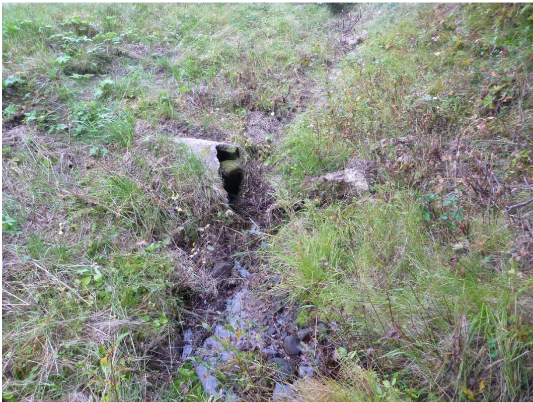
Järvträsk - karteringspunkt 2. Vägtrumma med diameter 0,5 m.
