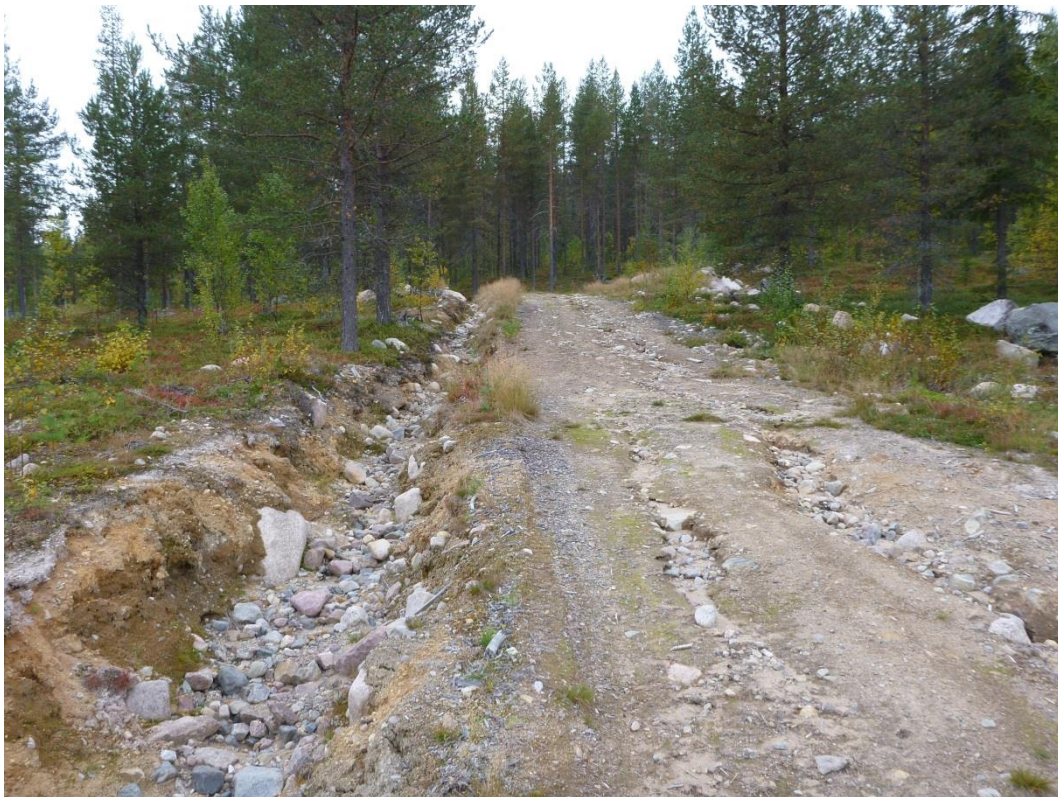
Prästberget - karteringspunkt 1. Erosionsbenägen finkornig morän, eroderat utmed dike och väggropp.
