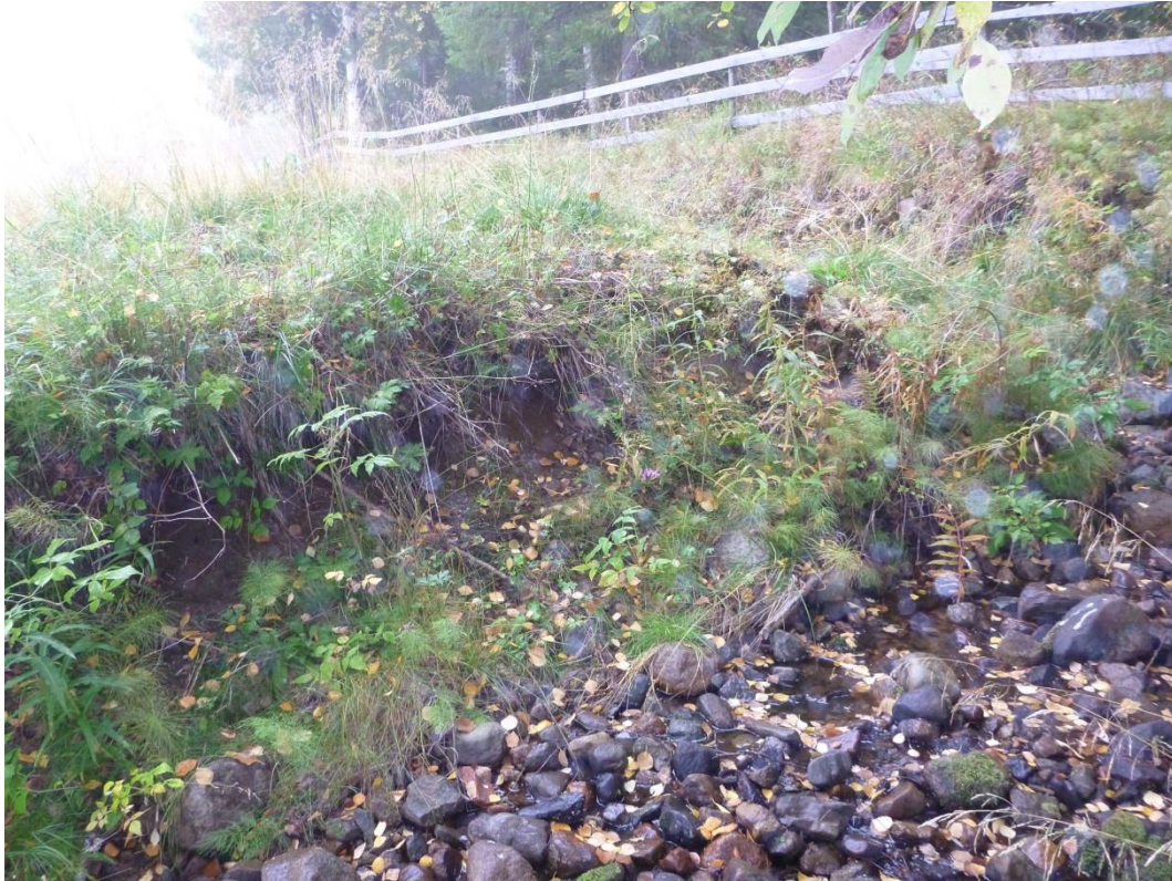
Gallejaur - karteringspunkt 4. Erosion i ravinens sidoslänter.
