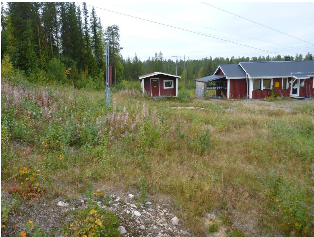
Prästberget - karteringspunkt 2. Bebyggelsen närmast moränslätten utgörs av värmestugor och byggnader till liftanläggningen, inga bostadshus finns i området.
