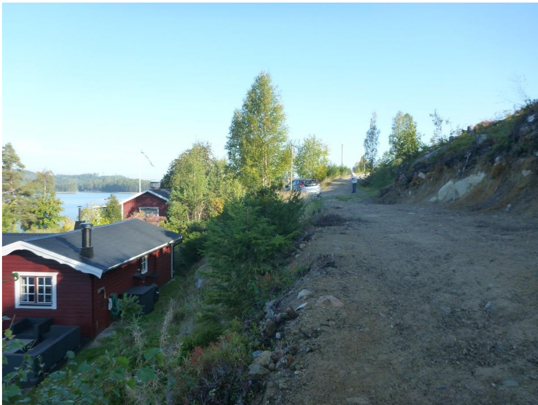
Ö Öjungsbo - karteringspunkt 2. Fritidshus vid en brant moränslänt och en anlagd väg med en släntlutning av 30-35°.
