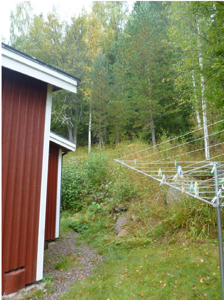
Sjuberget - karteringspunkt 5. Fritidshus i moränsluttning, schakt i slänten bakom huset.
