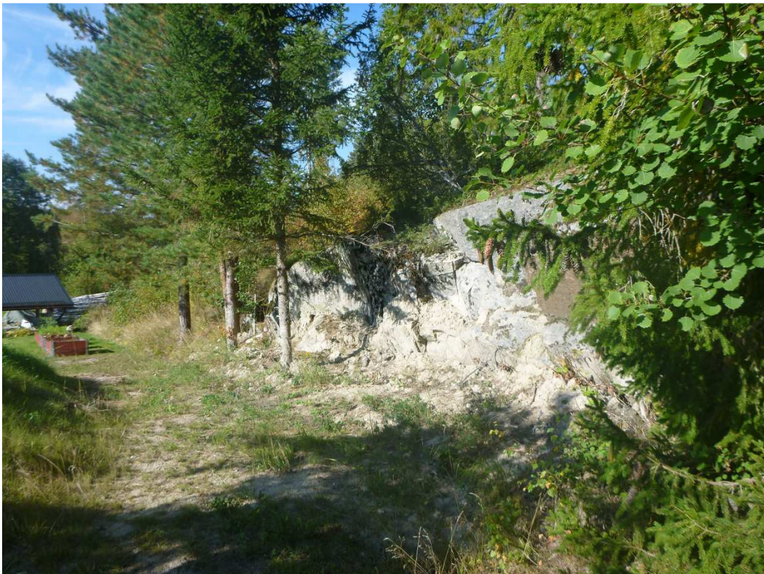
Rumpberg - karteringspunkt 1. Villabebyggelse i moränsluttning. Liten, kort, brant slänt. Stora block i slänten eller ev. berg i dagen.
