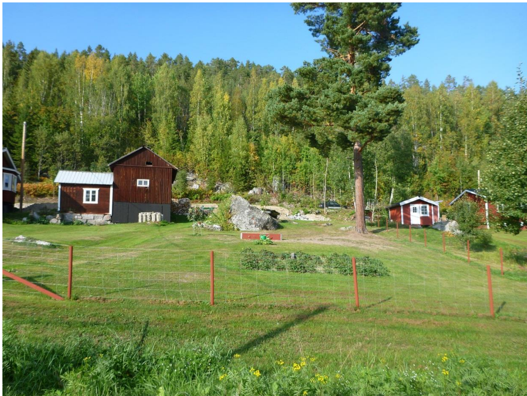
Sjörgrå - karteringspunkt 2. Fritidsbebyggelsen ligger nedanför en lång och brant slänt. Schaktning har utförts vid släntfot.
