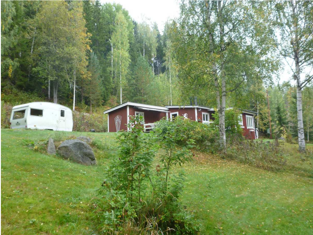
Sjuberget - karteringspunkt 5. Fritidshus i blockrik moränsluttning. Släntlutning 25° bakom hus.
