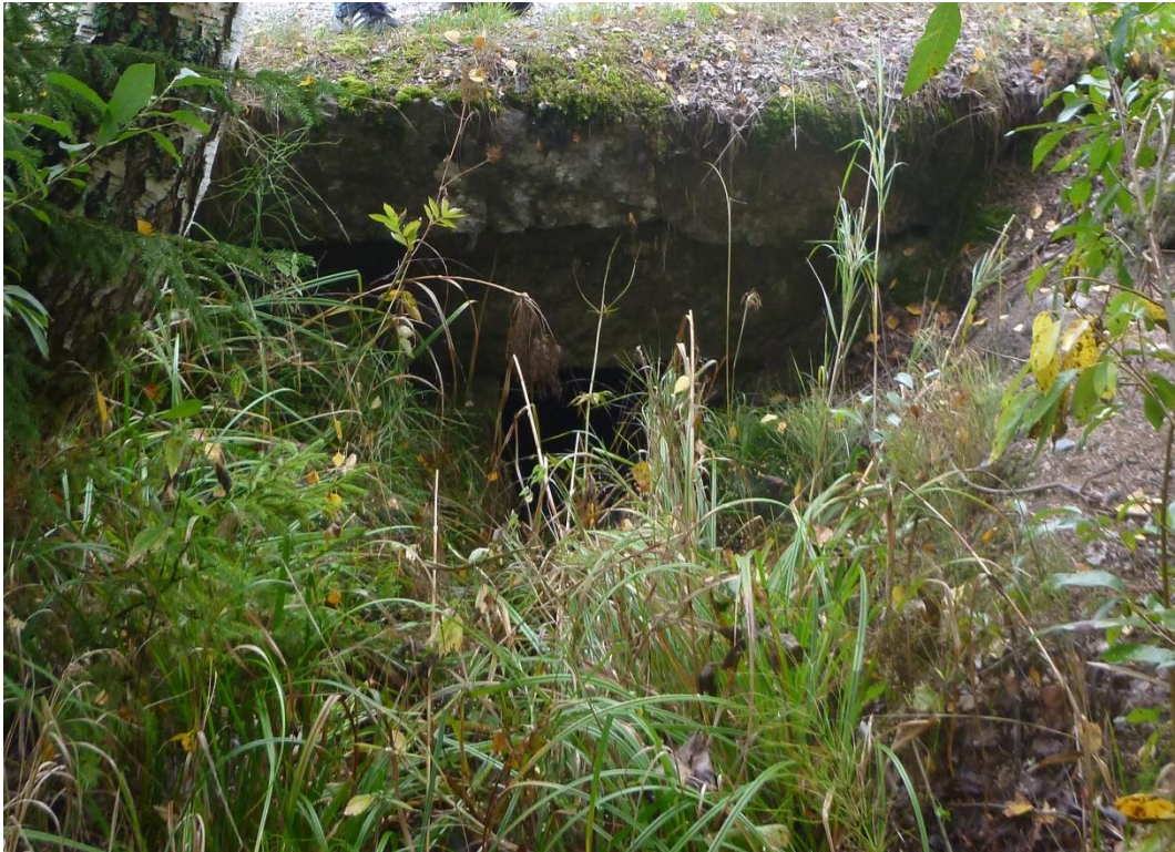
Nordsjö - karteringspunkt 4. Igenvuxen stensatt trumma under väg.
