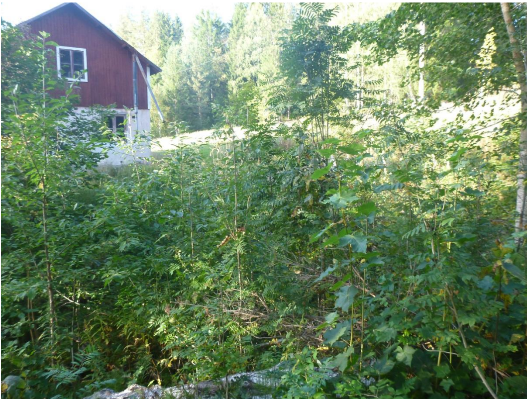
Röstbodarna - karteringspunkt 2. Mindre bäckravin med kraftig vegetation. Inga stabilitetsproblem föreligger.
