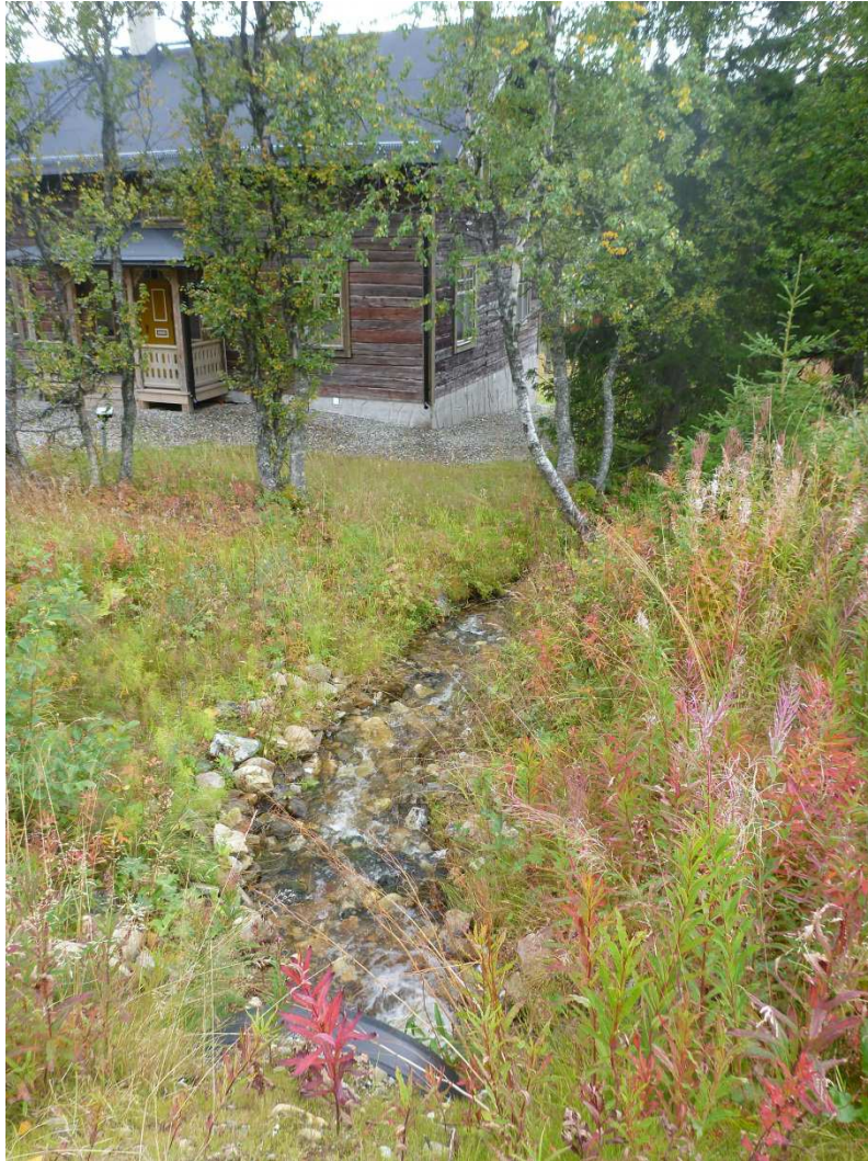
Vemdalskalet - karteringspunkt 2 Fritidshus vid bäck. Fara för översvämning och erosion.
