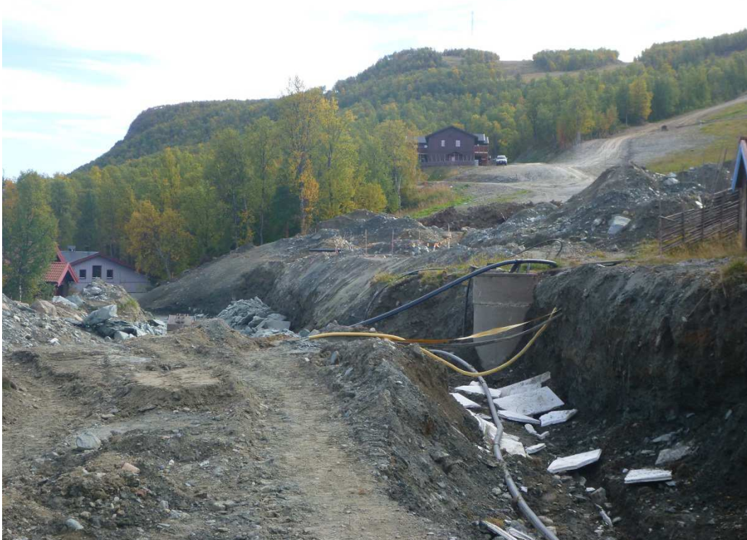
Ramundberget - karteringspunkt 9. Schaktning för ny tillfartsväg
