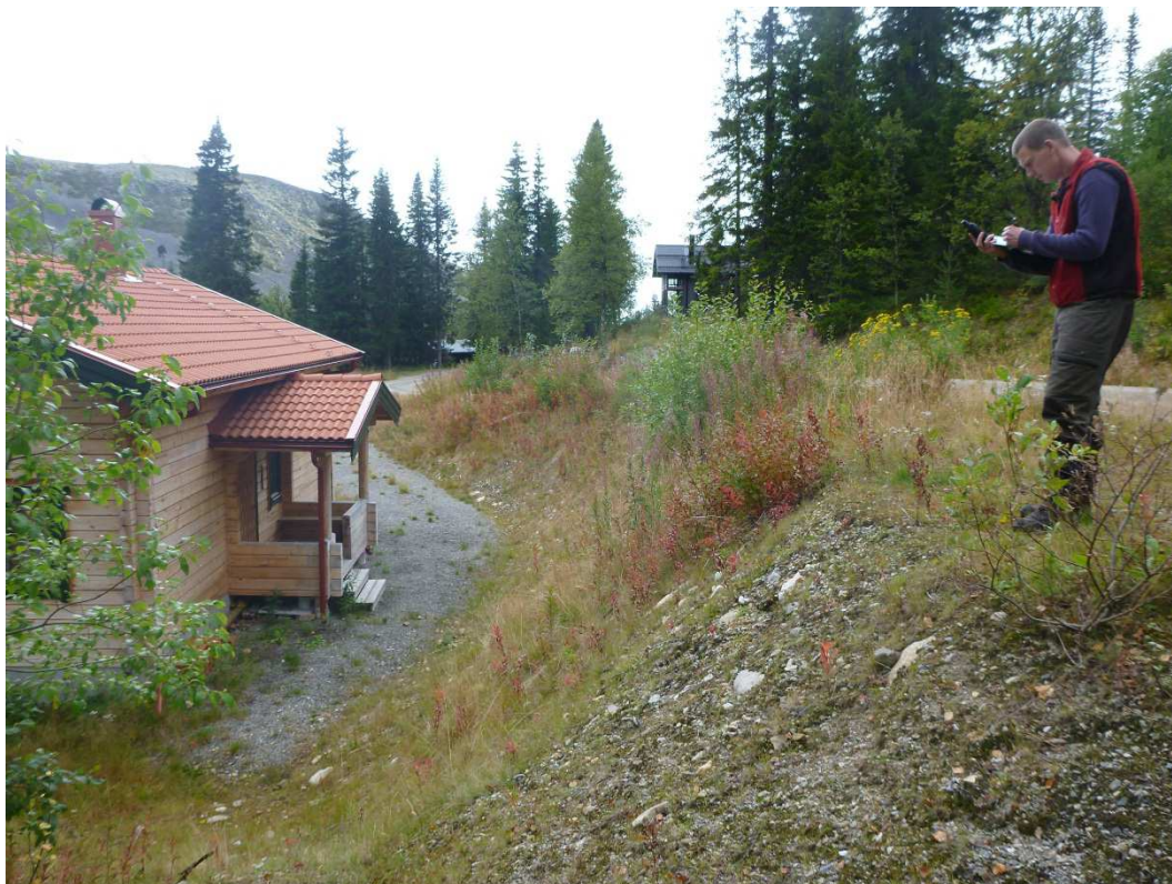
Vemdalskalet - karteringspunkt 5 Fritidshus i schaktad moränsluttning.
