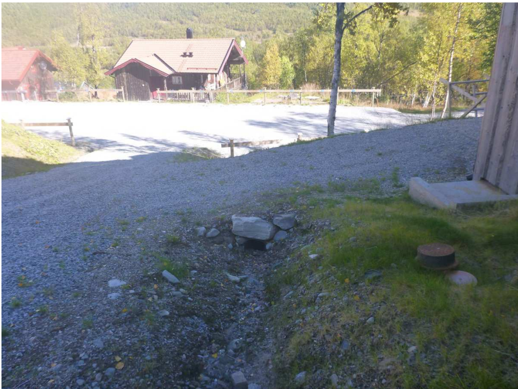
Ramundberget - karteringspunkt 7. Otillräcklig dagvattenhantering som kan leda till erosion, slamströmmar och ras.
