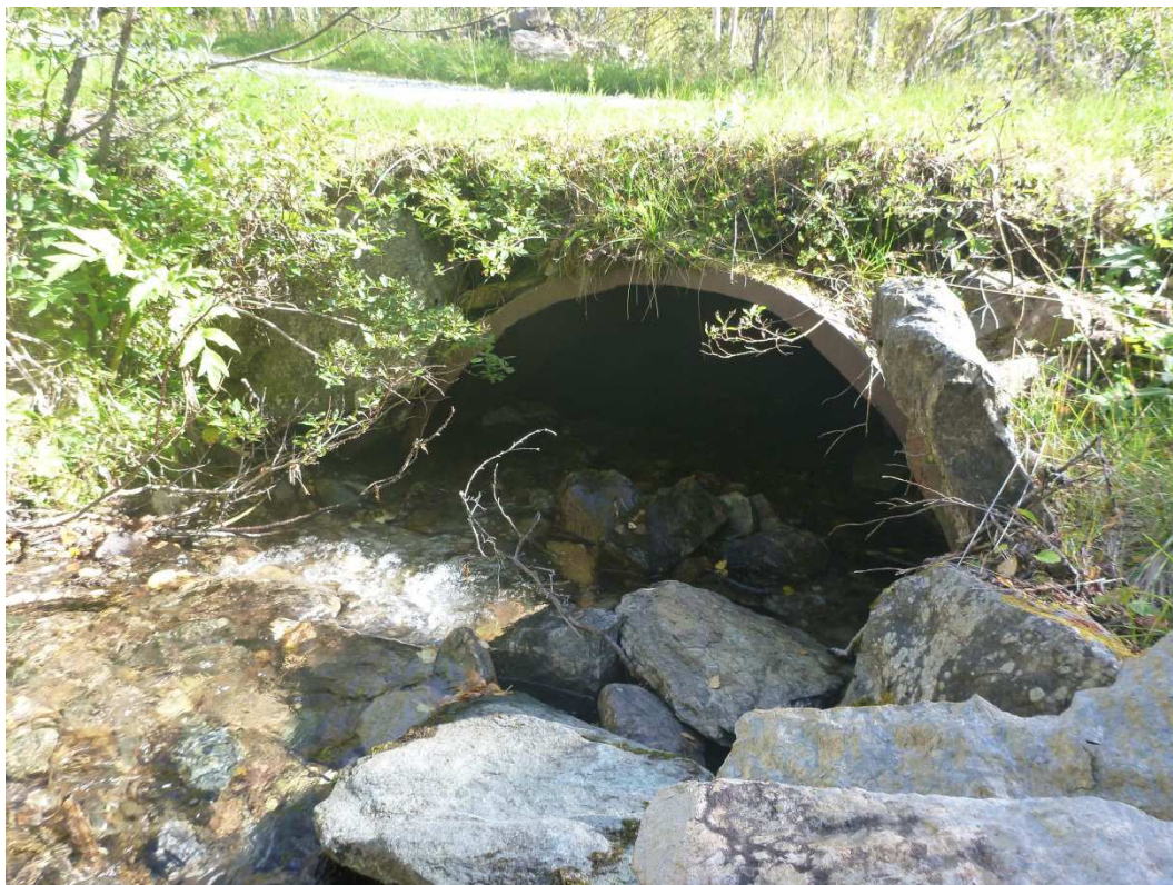
Tännaldalen - karteringspunkt 6 Trumma under grusväg med avsatt jordmaterial.
