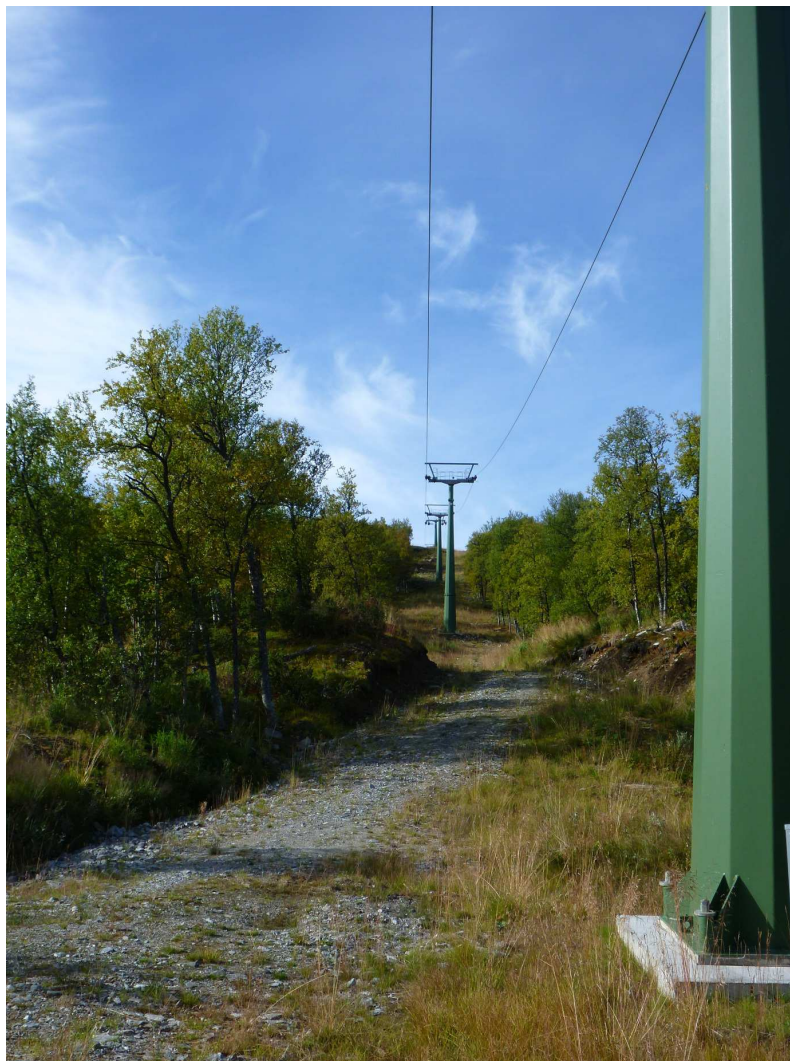
Hamra - karteringspunkt 5. Något eroderat i diken och längs med skidpisten.
