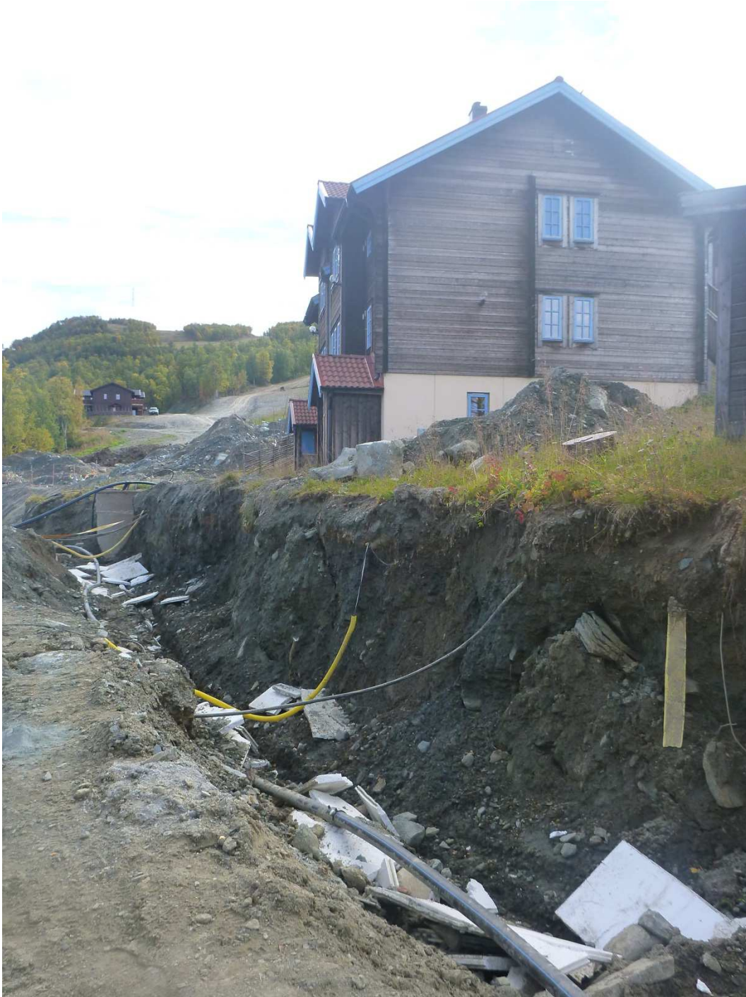
Ramundberget - karteringspunkt 9. Schaktning för ny tillfartsväg
