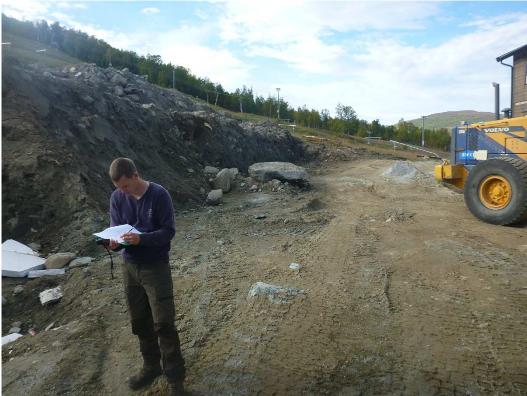
Ramundberget - karteringspunkt 9. Schaktning för ny tillfartsväg.
