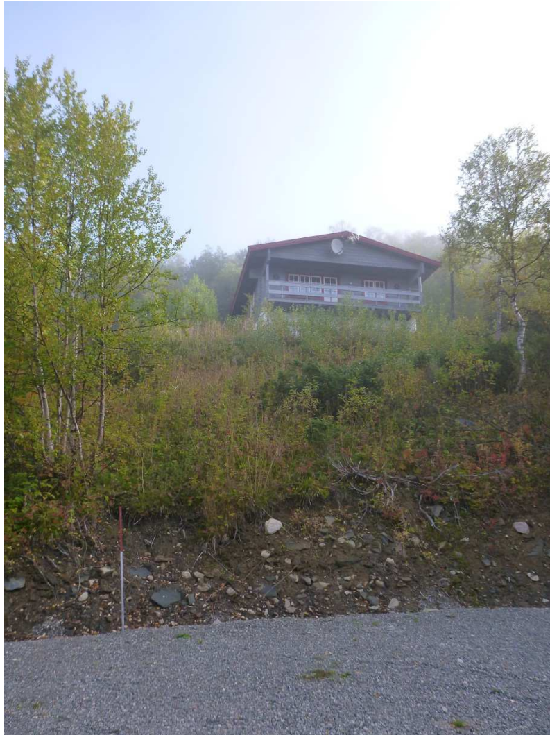
Hamra - karteringspunkt 1. Fritidshus i moränsluttning, schaktat i släntfot.
