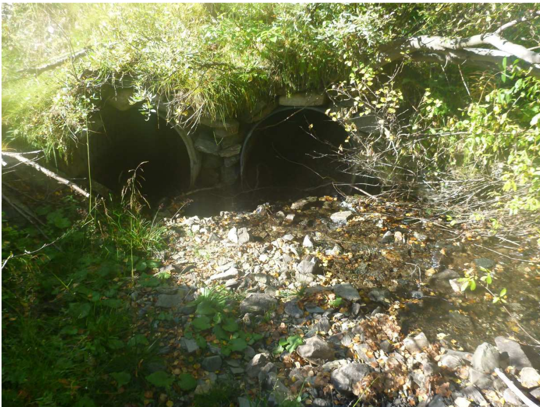
Bruksvallarna - karteringspunkt 4. Transporterat material finns i trummorna som hotas av dämning och därmed bortspolning av väggroppen.
