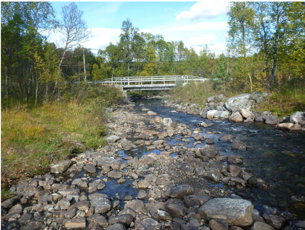
Hagströmsvallen - karteringspunkt 1. Bro nedströms kontrollpunkten.
