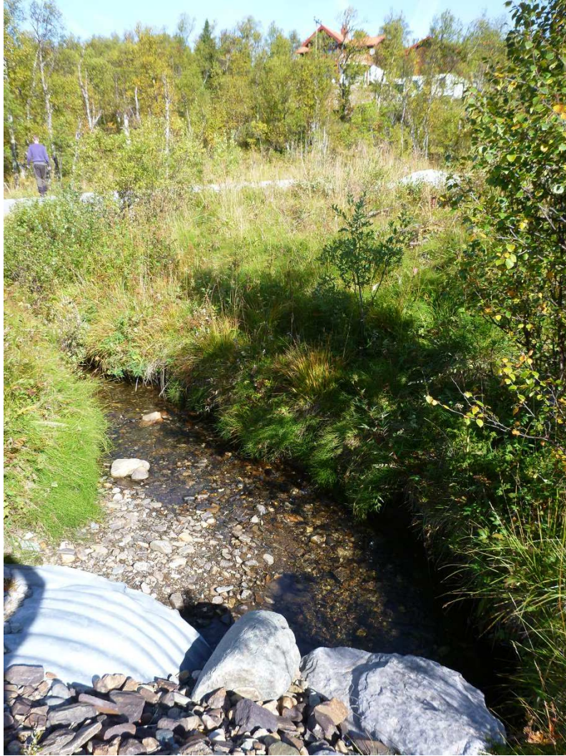
Tännalden - karteringspunkt 3. Bäck som går i trumma under grusväg. Avsatt jordmaterial.
