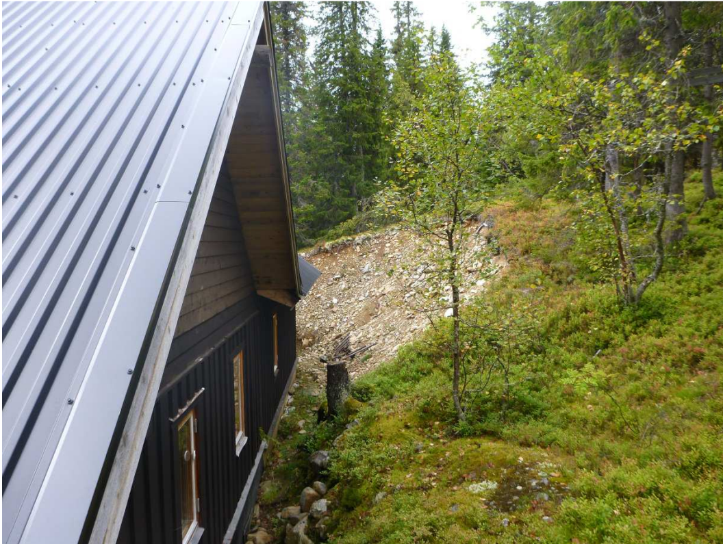
Vemdalskalet - karteringspunkt 4 Fritidshus i schaktad slänt i moränsluttning.
