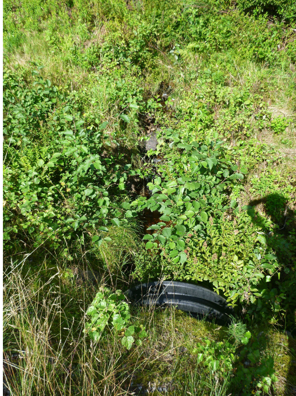
Karteringspunkt nr 42. Närbild på trumma under väg i södra delarna av Ambjörby.
