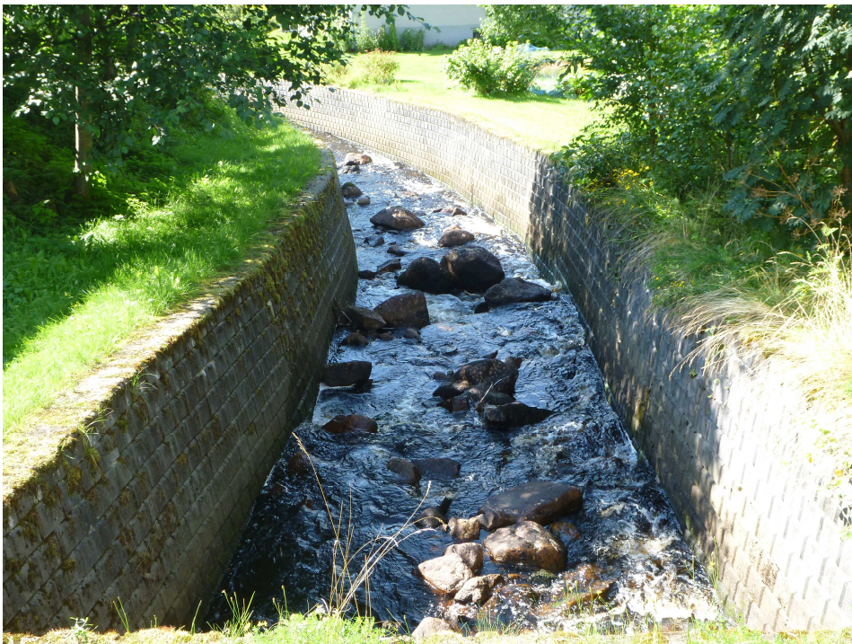
Karteringspunkt nr 16. Kvarnbäcken är kanaliserad och muren var vid karteringstillfället, 2012-08-14 intakt.
