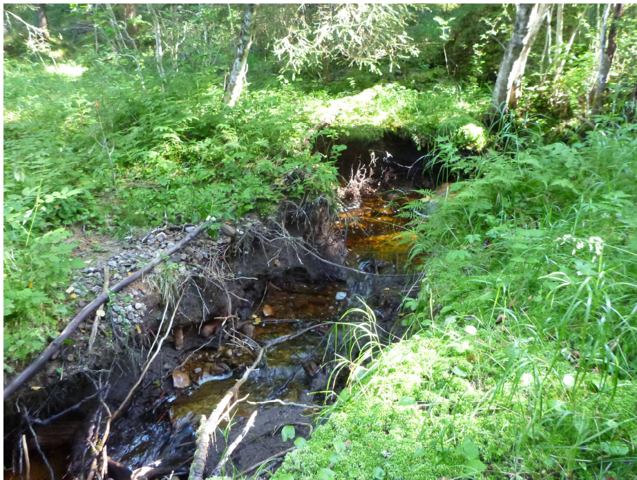
Karteringspunkt nr 4. Erosion i botten och på slänterna vid Näckån.
