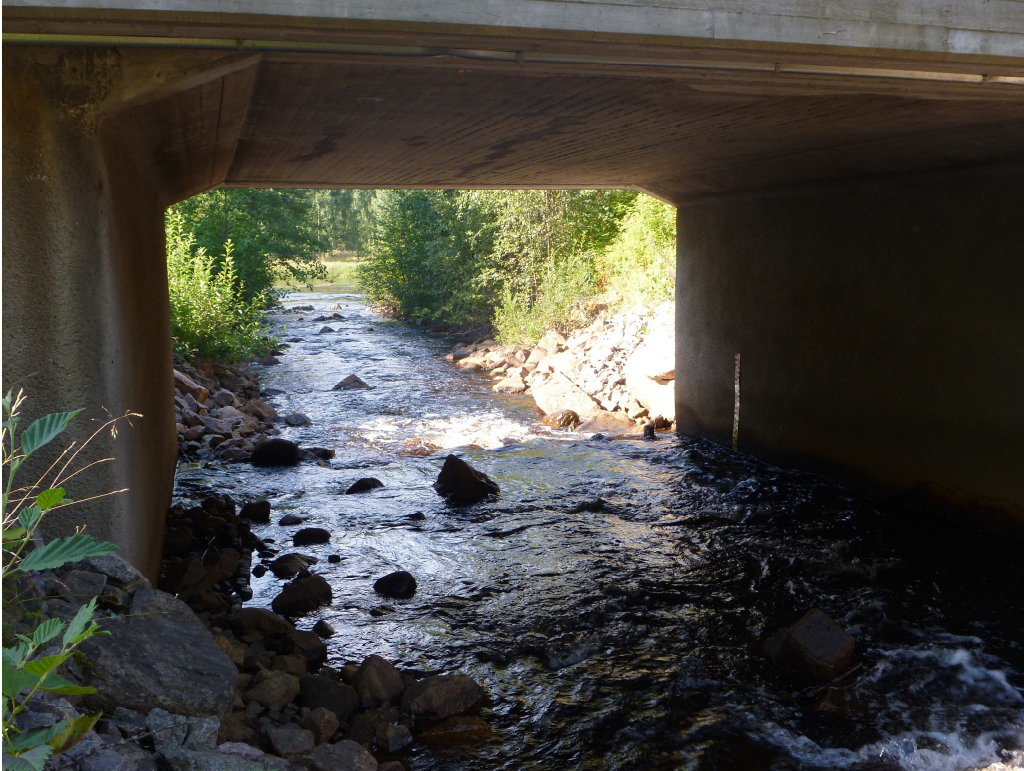
Karteringspunkt nr 1. Vägbro i betong över Näckån.
