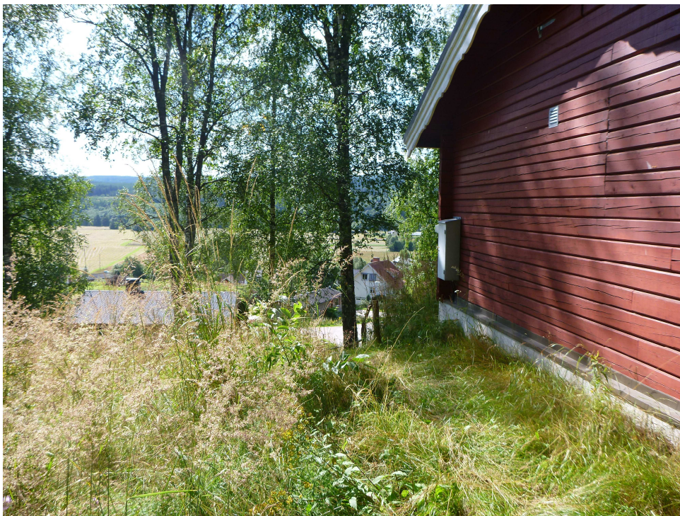
Karteringspunkt nr 38. Ravin i glacial silt och sand. Bebyggelsen nära slänkrönet vid grund ravin. Kraftig vegetation i slänterna.
