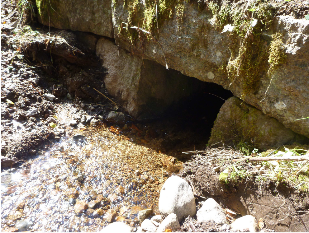
Karteringspunkt nr 9. Mästarbäcken. Stensatt trumma (30x40 cm) under mindre väg.
