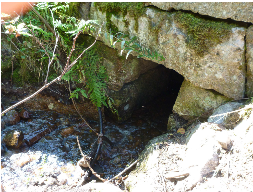
Karteringspunkt nr 7. Stensatt trumma vid Stretbäcken. Inga avlagringar i trumman.
