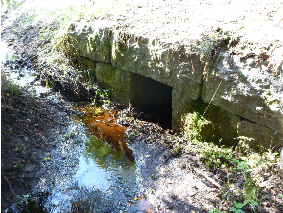
Karteringspunkt nr 8. Mindre bäck i Slättene. Stensatt trumma, 50x40 cm.
