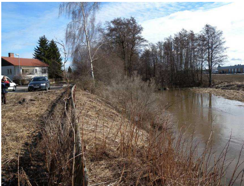
Figur 4-2 Valstaån – Villabebyggelse vid Valstaån, Köping, Foto: SGI
