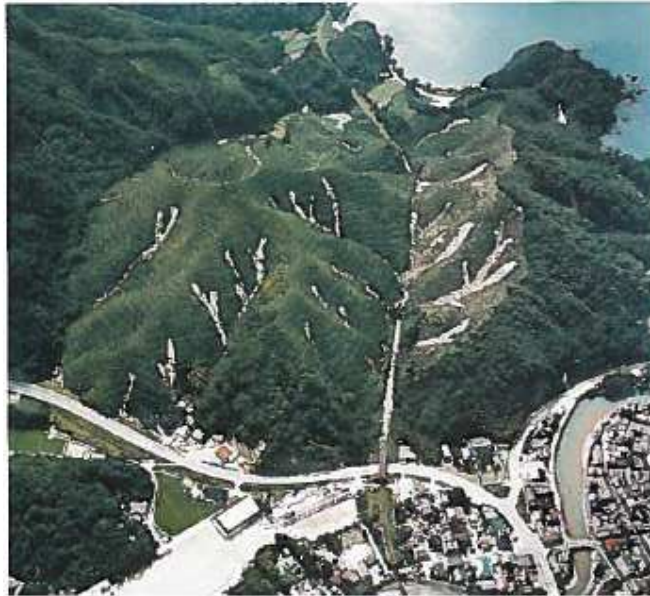
Figur 6-4 Exempel på kontrast mellan avverkade sluttningar och sluttningar med ursprunglig skogstäckning. Släntstabiliteten har blivit mycket sämre inom det avverkade området där nya skred och raviner har uppkommit, Nagasaki, Japan, United Nations (1996). Foto: M. Watanabe.
