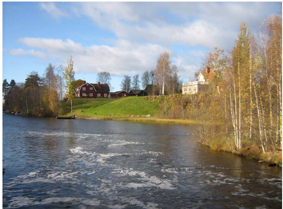
Erosion utmed Enån genom Rättvik i Dalarnas län.
