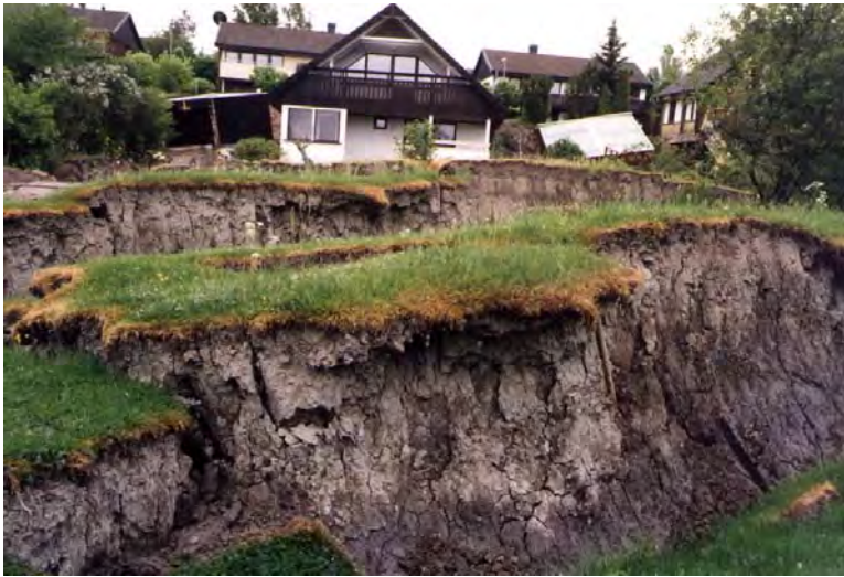
Figur 9-7. Skred i Vagnhärad 1997. Foto: SGI.
