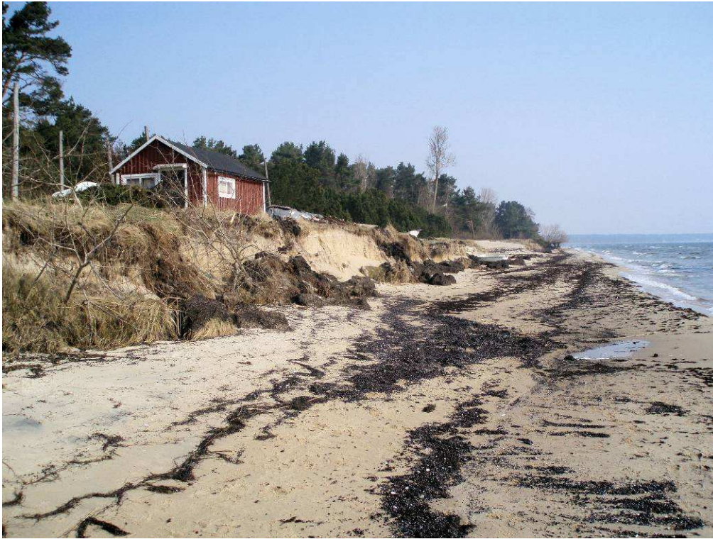
Figur 6-1. Exempel på erosions-skador vid havskust. Stranderosion vid Åhus. Foto: Kristianstads kommun.
