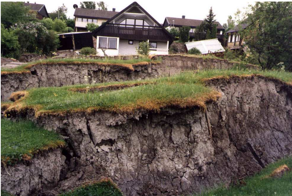
Figur 8-2. Skred i Vagnhärad, 1997. Foto: SGI.
