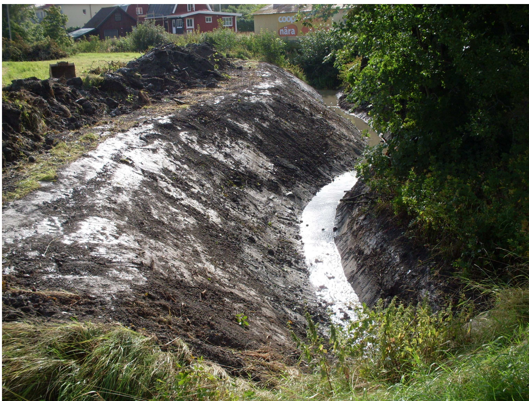
Bild 6-1. Rensning av lerslänter och fördjupning av Dyån, som avvattnar de södra delarna av området Sunnerby-Spångsbro. (Foto: SGI)
