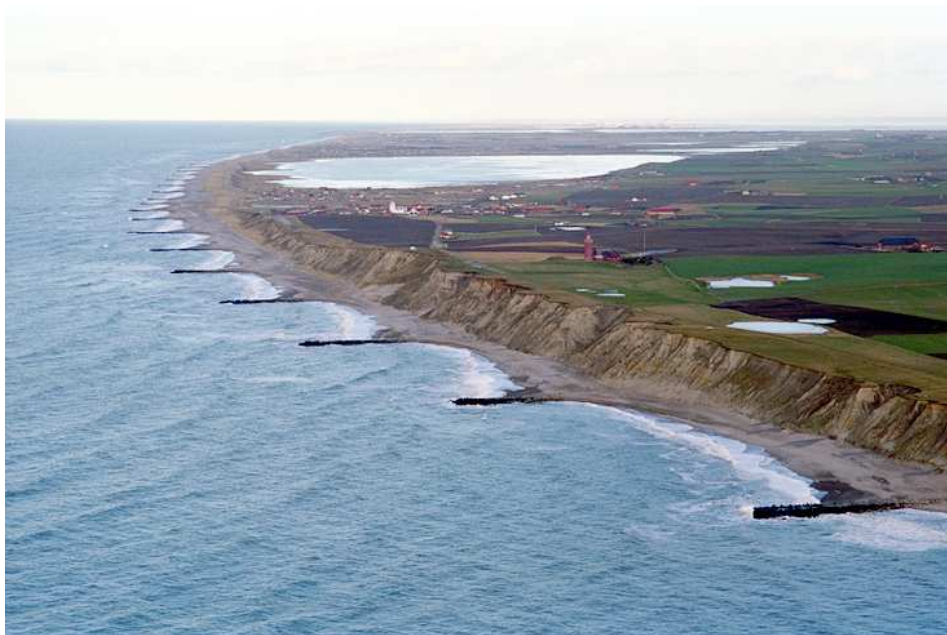
Hövder för stabilisering av en kuststräcka . (Foto: Kystdirektoratet, Danmark)
