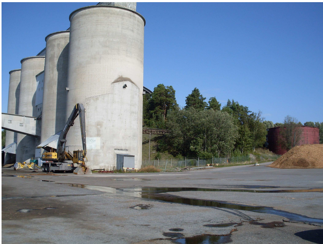
Bild 7-1. Siloanläggningar i de södra delarna av industriområdet i Stora Vika. (Foto: SGI)
