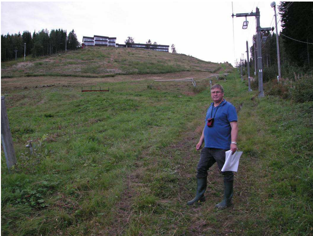
Bild 10. Fotograferat från punkt 7 i sydvästlig riktning uppför pisten. Gräsbevuxen pist och inga indikationer på bar jord och erosionsskador förutom läkta spår efter schaktning för markförlagda vattenledningar för snökanoner.
