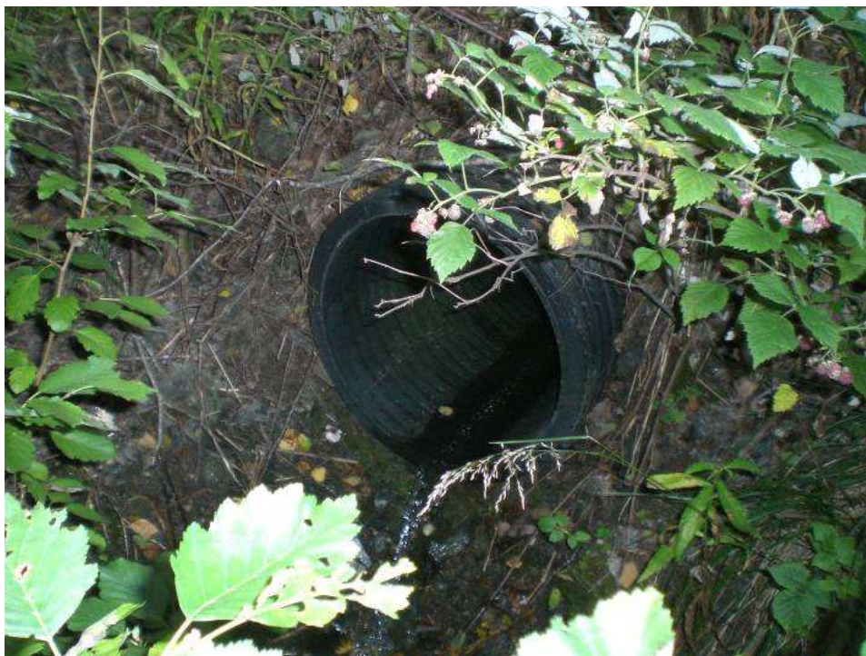
Bild 4. Fotograferat i punkt 3, södra sidan av vägen inloppet till vägtrumma i närbild, ø 500 mm.
