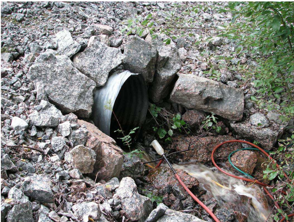
Bild 2. Fotograferat vid punkt 2, vägtrummans utlopp. Inga indikationer på materialtransport.
