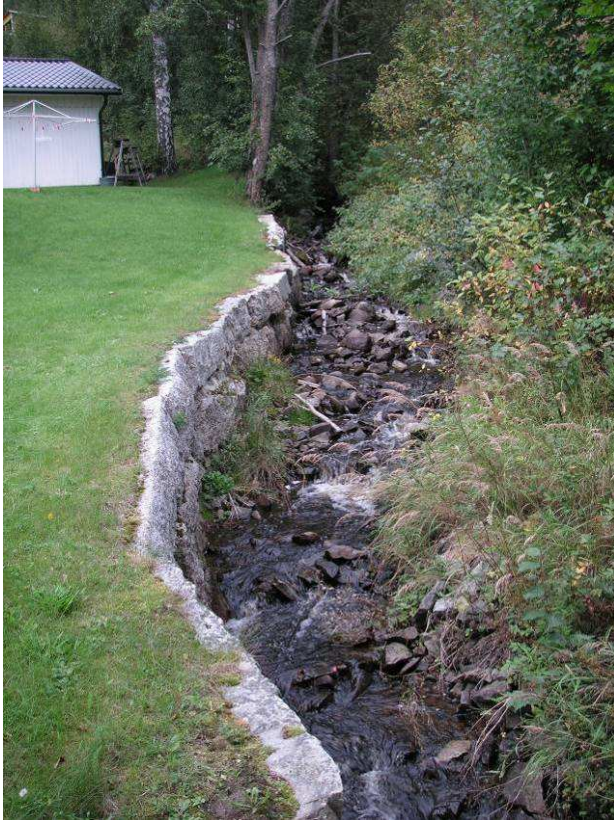
Bild 7. Fotograferat från punkt 5 i nordlig riktning. Stödmur i kanten på bäcken invid en villatomt, inga tecken på materialtransport i bäckfåran.
