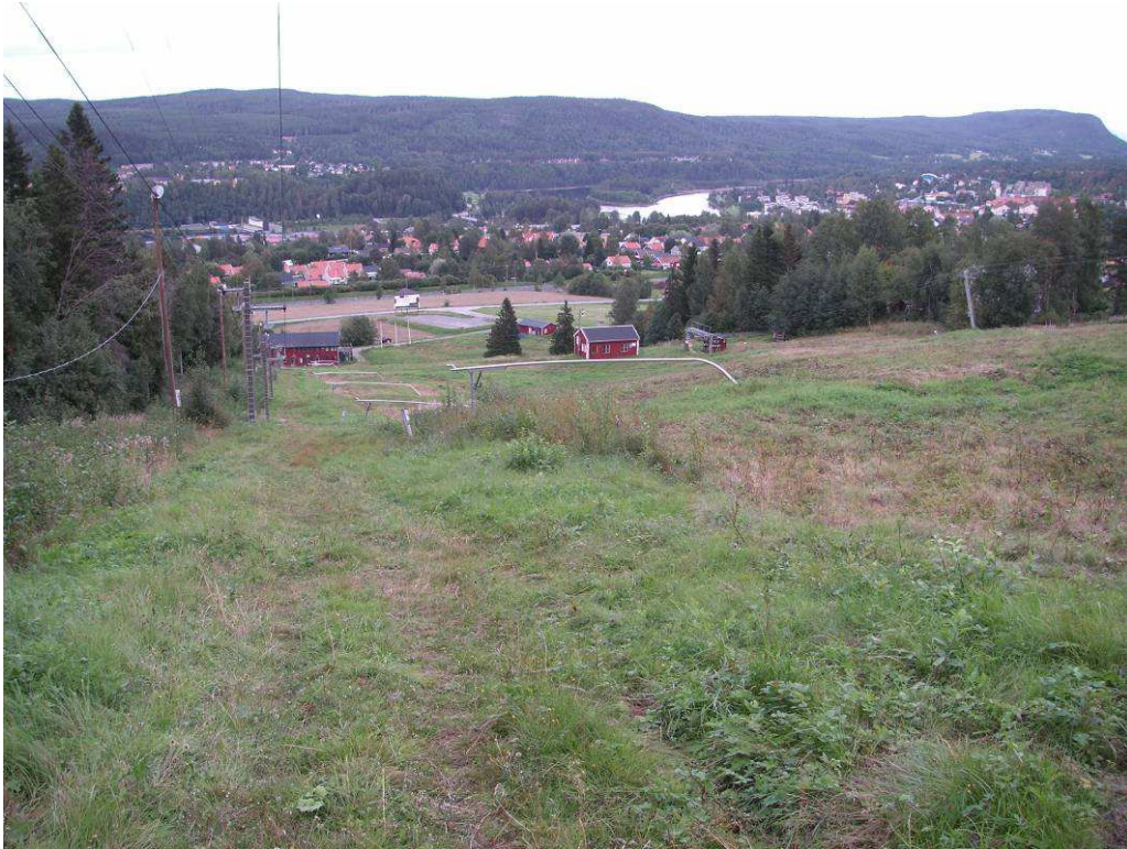
Bild 9. Fotograferat från punkt 7 i nordostlig riktning nedför pisten. Läkta markskador efter schaktning för markförlagda vattenledningar för snökanoner.
