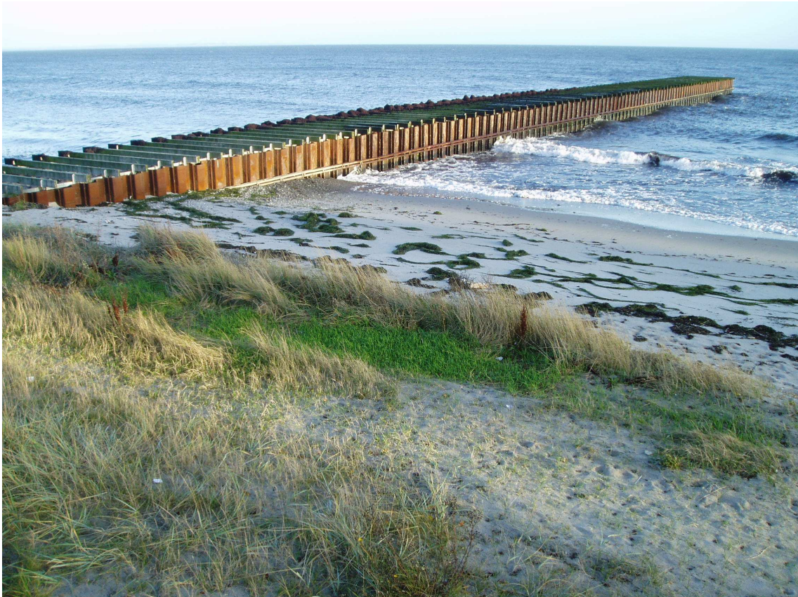
Figur 5-3. Hövder som skydd mot stranderosion vid Ystad Saltsjöbad. Foto: SGI.
