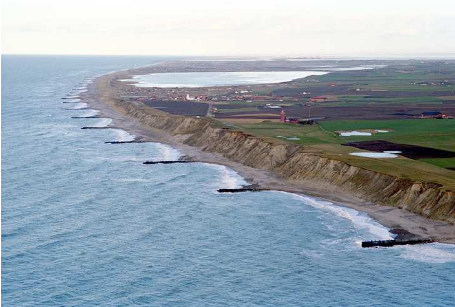
Figur C. Hövder för stabilisering av en kuststräcka . (Foto: Kystdirektoratet, Danmark)
