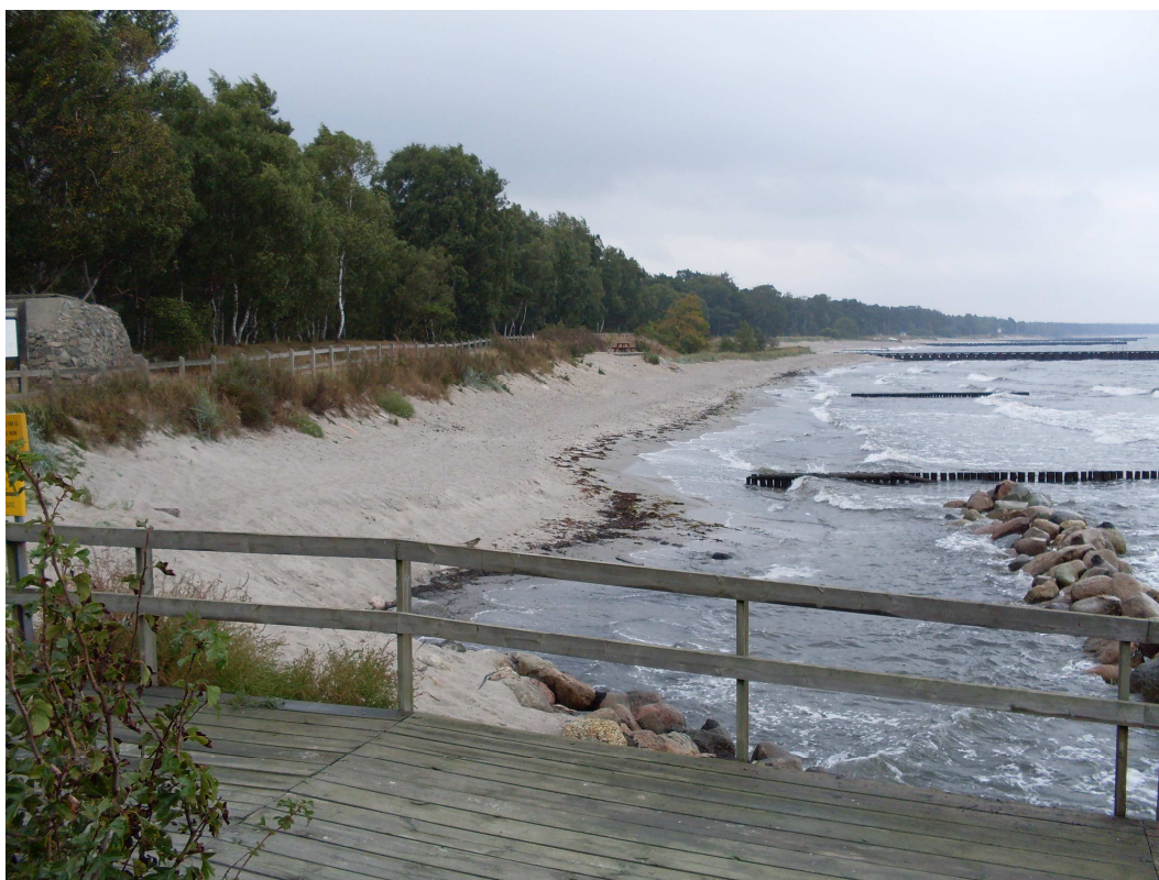
Figur 6-3. Erosion vid Ystad Saltsjöbad 2009. Foto: SGI
