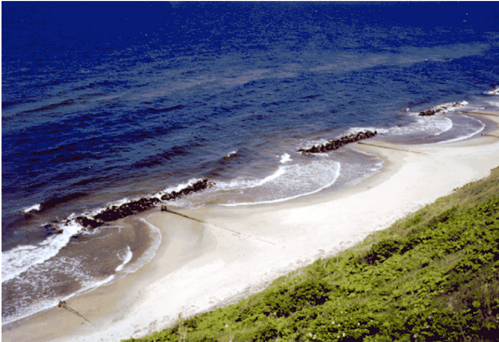
Figur B. Vågbrytare. (Foto: Kystdirektoratet, Danmark)
