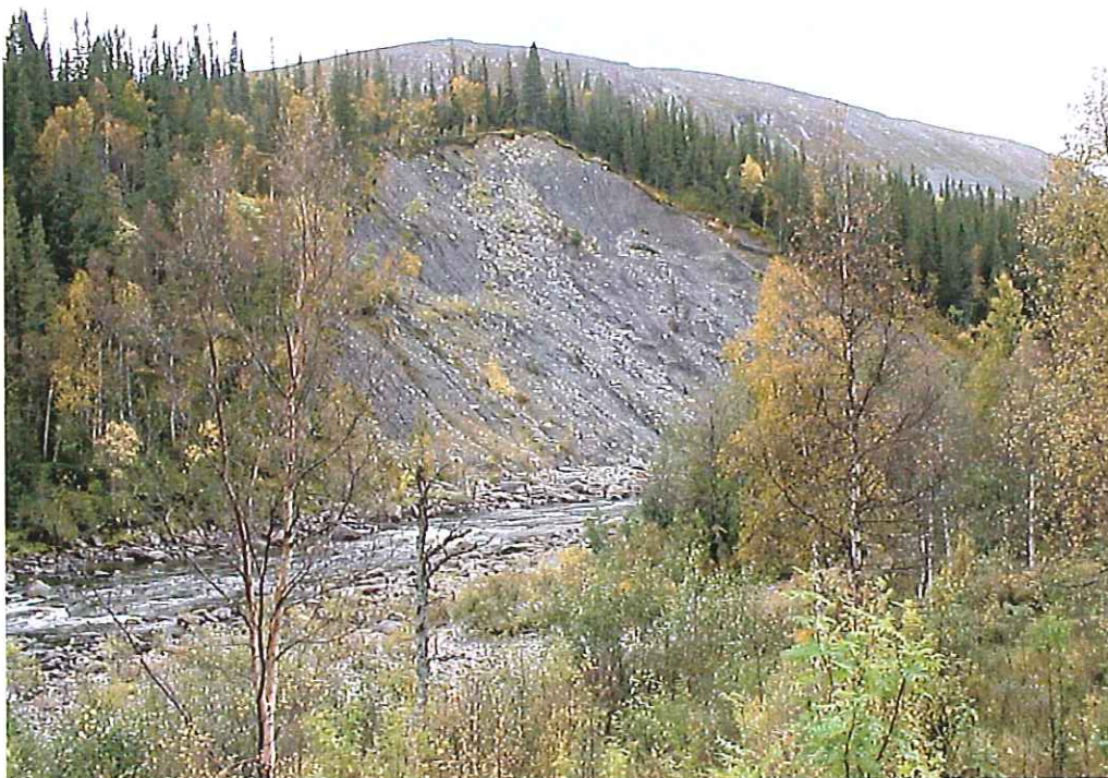
Bild 6:2 Fjällhalsen, ras i älvslänten på andra sidan älven.
