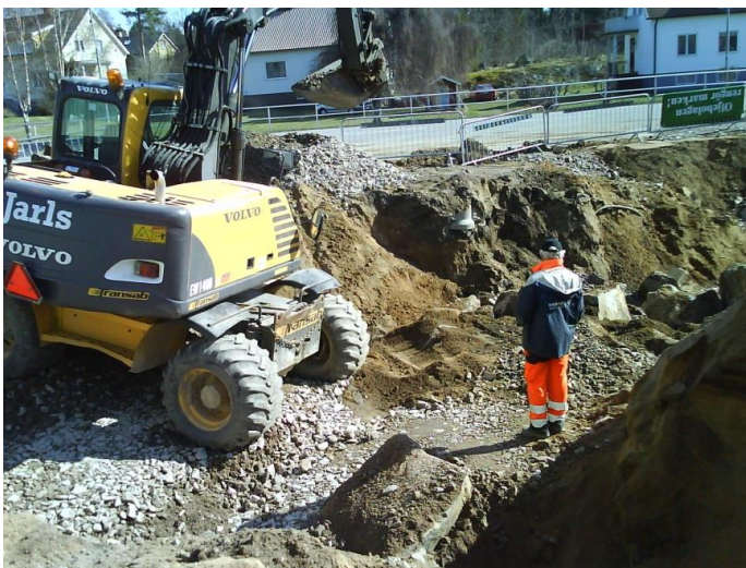
Figur 7.1 Schaktning och borttransport av förorenad mark. (Foto: SGI)
