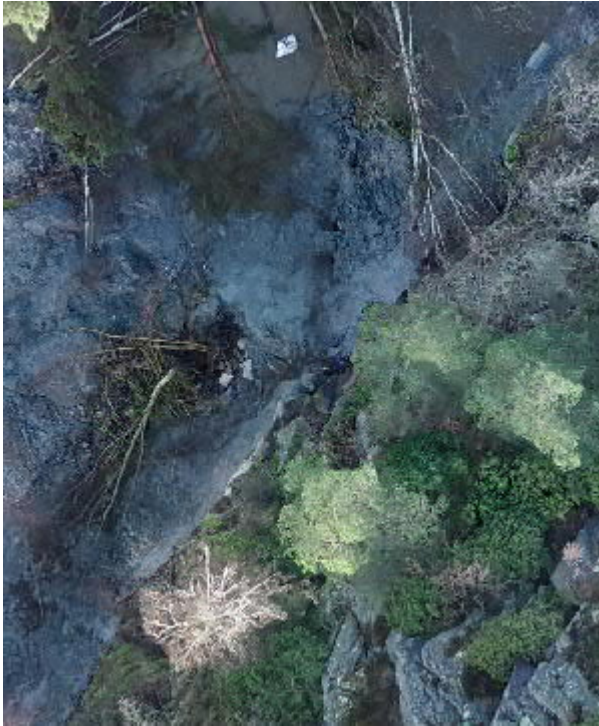
Figur 16 Detaljbild över den branta slänten, varifrån lemassorna har släppt. Här finns både skymmande träd uppe på höjden och träd nere i själva skredområdet som lutar in över slänten, vilket gör det mycket svårt att fånga skredets bakkant. Spridningstillstånd drönardata Dnr LM2020/003327.
